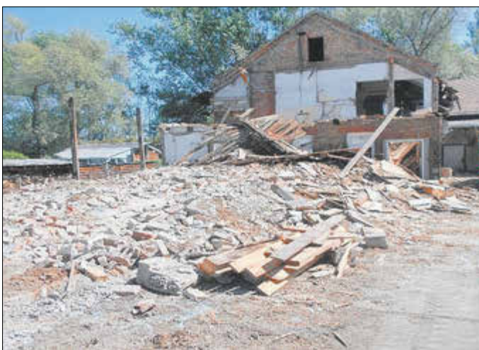
Während der Abrissmaßnahme
