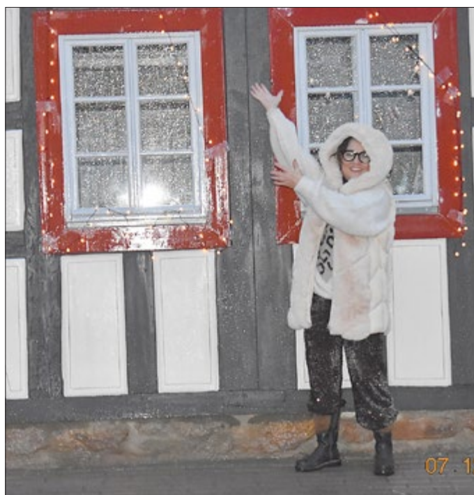
Vor dem frisch sanierten Knöpfer-Haus: Carola Busse hieß die Gäste herzlich willkommen. Am Vortag waren gerade die Baugerüste gefallen. Foto: J. Thiele
